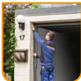
Sopralluogo per verifica dimensionale
